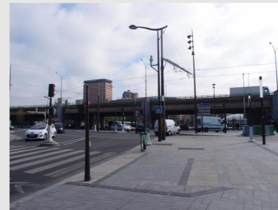
Requalification des espaces publics de la Porte de Pantin
