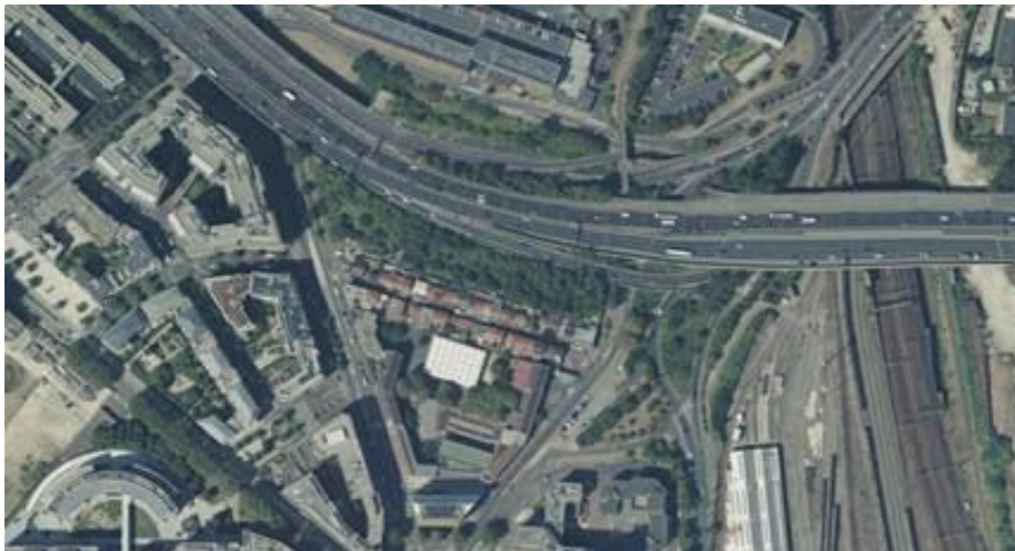
Situation avant aménagement
