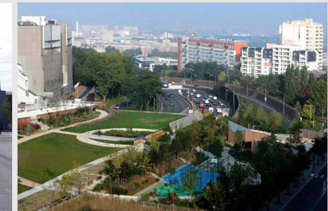
Jardin Serge-Gainsbourg sur la couverture du boulevard périphérique à la Porte des Lilas
